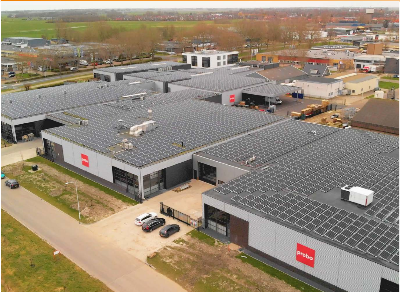
Drukkerij Probo in Dokkum breidde uit met bedrijfshallen en ook met zonnepanelen.
