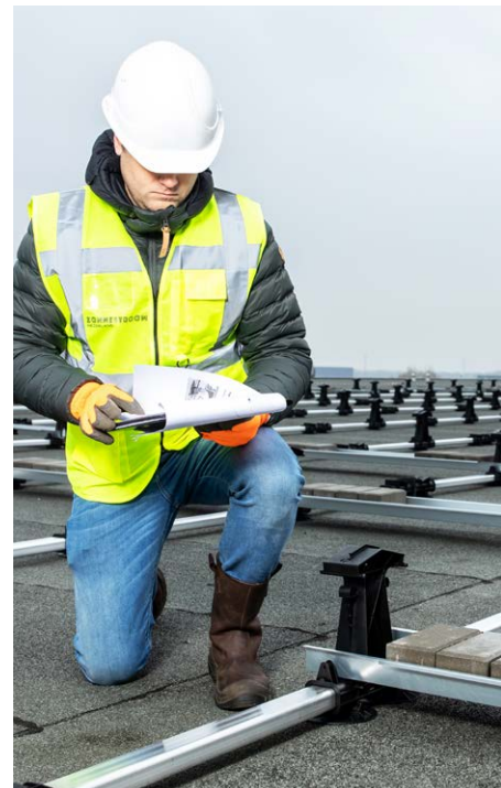
Esdec controleert ter plekke de montage van de bevestigings-systemen.
